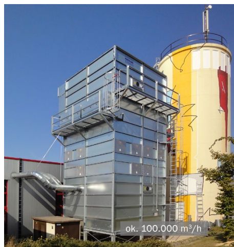
Filtr z wygarniaczem obrotowym MultiStar z regeneracją sprężonym powietrzem – JET
