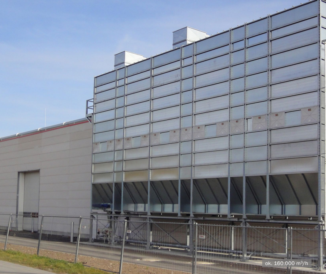
Filtr MultiStar z przedmuchami rewersyjnym powietrzem, z pustym modulem wdmuchowym • Produkcja mebli
