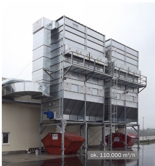
Filtr ślimakowy MultiStar z regeneracją sprężonym powietrzem • Przebudowa wnętrza
