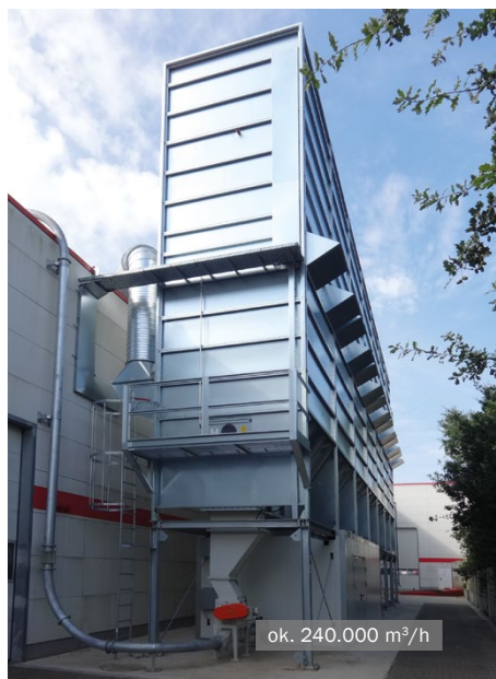
Filtr MultiStar z przedmuchami rewersyjnym powietrzem • Producent kuchni
