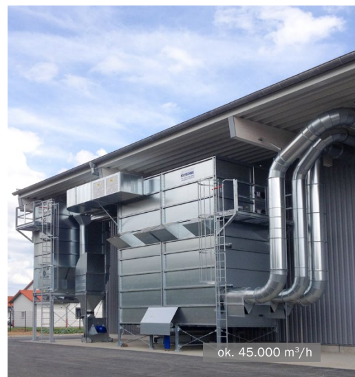
Filtr Jet MultiStar • Produkcja domów prefabrykowanych
