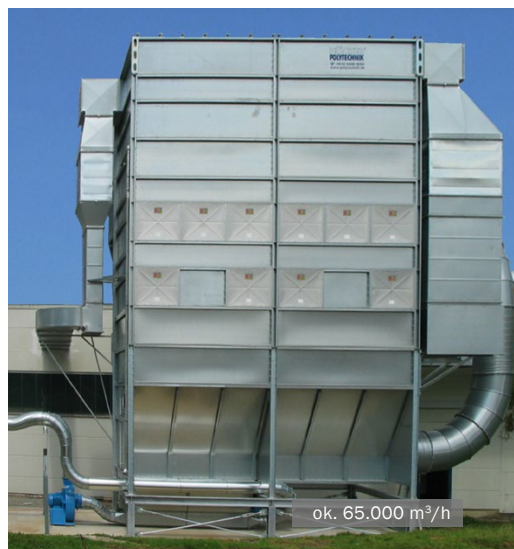
Filtr śluzy MultiStar z nadmuchiwaniami • Dostawca mebli
