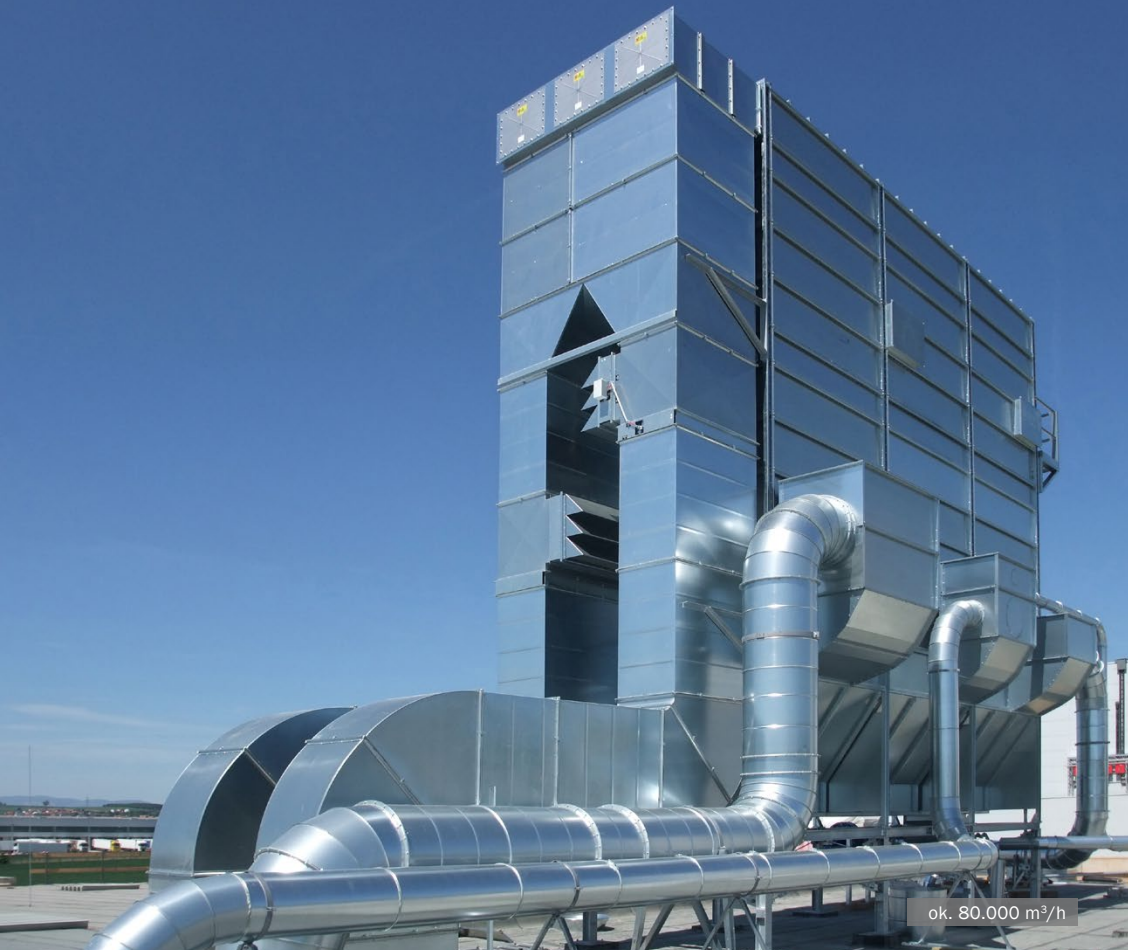
Filtr ślimakowy MultiStar z otrzepywaniem przedmuchami rewersyjnym powietrzem • Produkcja sprzętu sportowego
