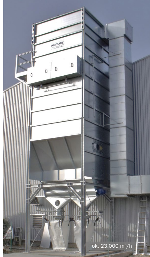
Filtr MultiStar z regeneracją sprężonym powietrzem – JET w branży domów prefabrykowanych
