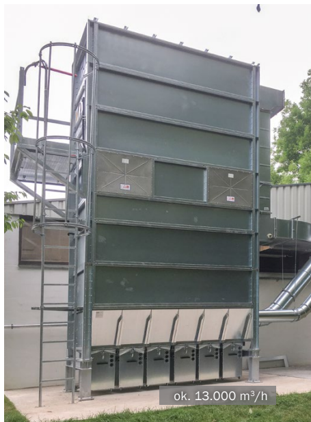
Filtr MultiStar odworkowujący z pojemnikami w obróbce drewna
