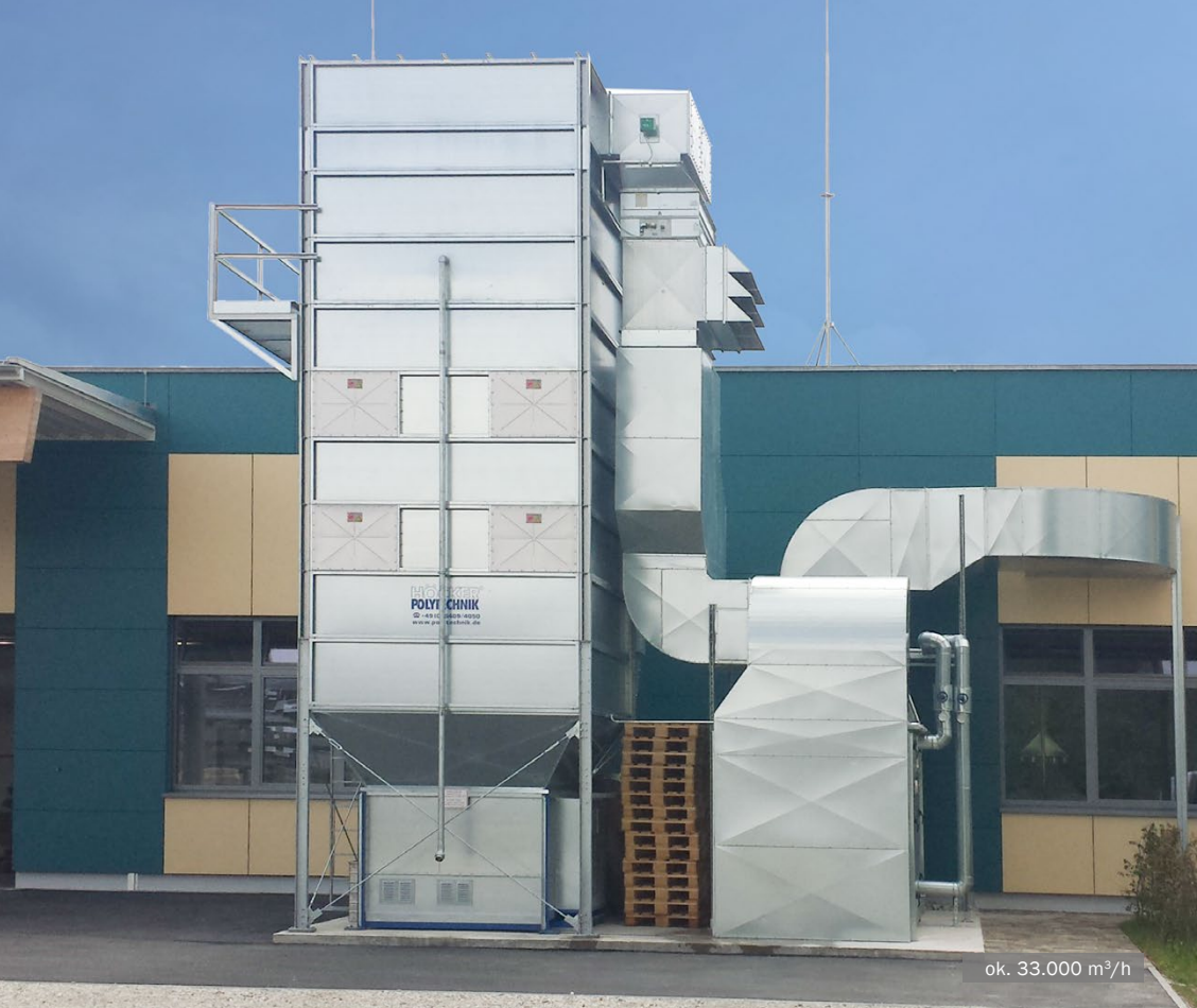
Filtr MultiStar z brykociarką razem z odzyskiem ciepła • Kuratorska placówka oświatowa
