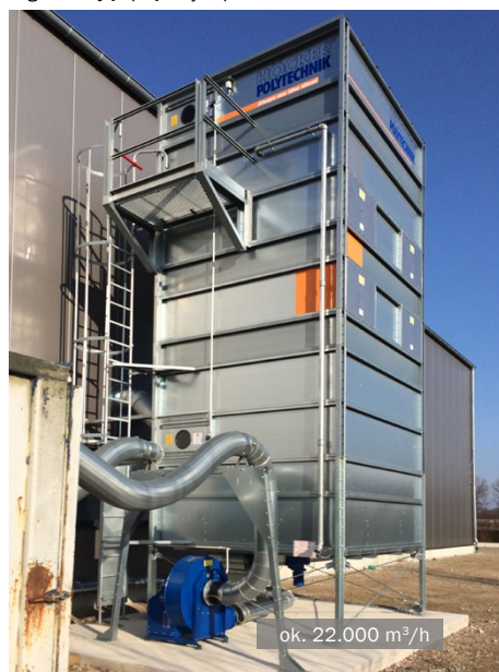
Filtr wyładowczy z wygarniaczem obrotowym MultiStar • Produkcja lepiszcza
