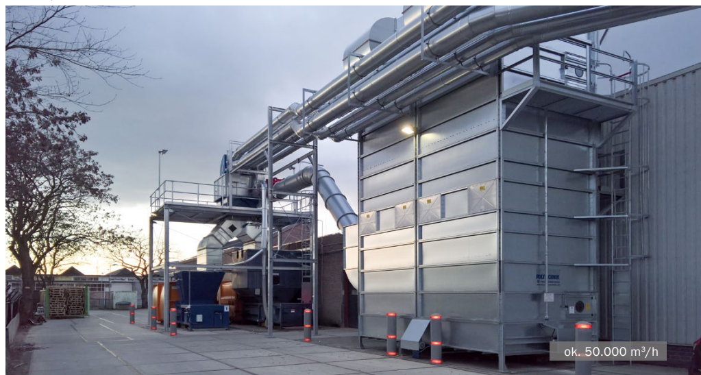
Filtr przeciwobny MultiStar z czyszczeniem strumieniem wody • Przemysł poligraficzny i opakowaniowy
