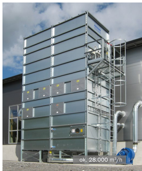
Filtr powietrza oczyszczającego MultiStar • Produkcja Thermowood
