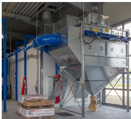
Filtr patronowy JET do kabin do piaskowania
