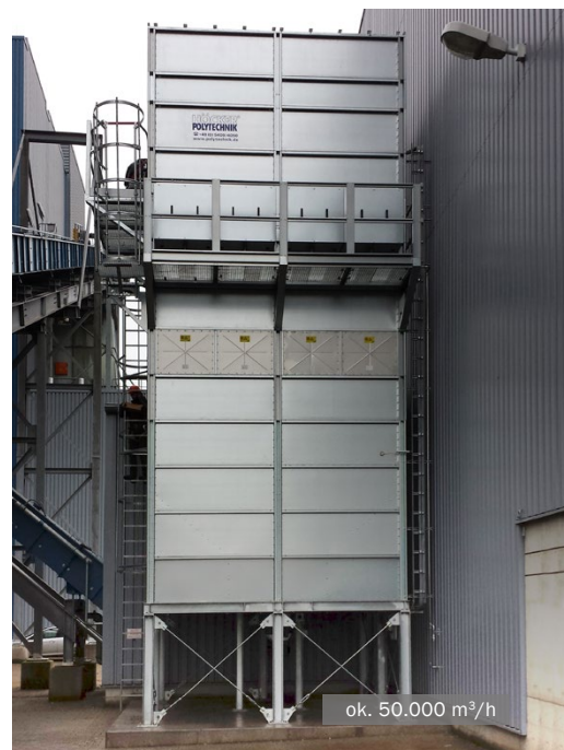
Filtr z wygarniaczem obrotowym MultiStar • Elektrownia na biomase
