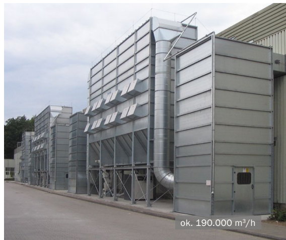
Filtr MultiStar z przedmuchami rewersyjnym powietrzem • Producent kuchni
