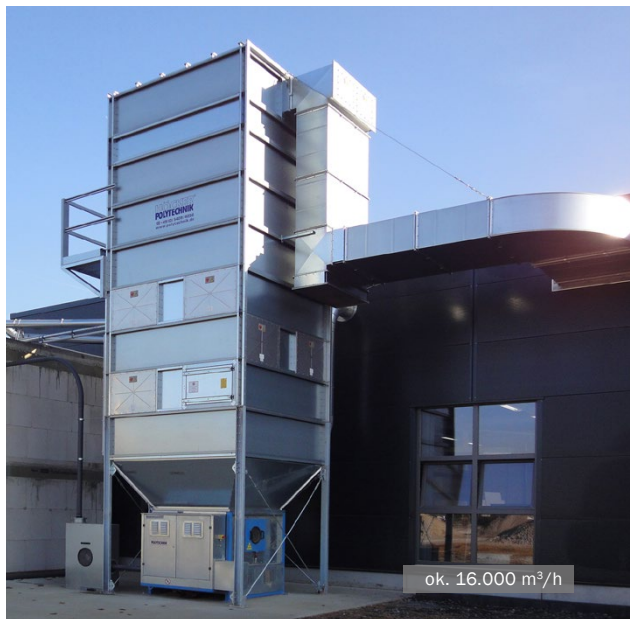
Filtr MultiStar z brykociarką • Przebudowa wewnątrz
