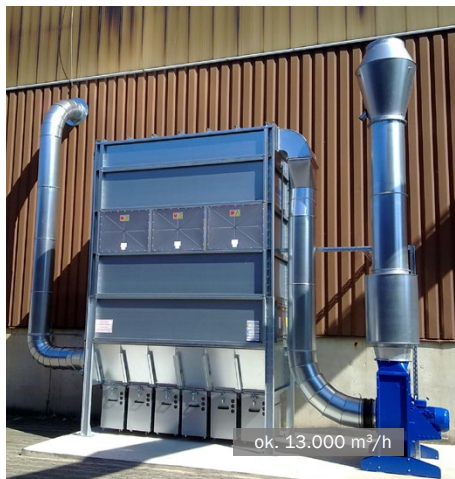
Filtr MultiStar odworkowujący z pojemnikami - produkcja mebli
