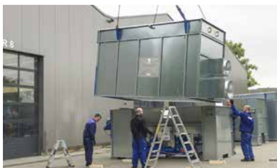
Oba górne moduły umieszczane na module rozładunkowym.
