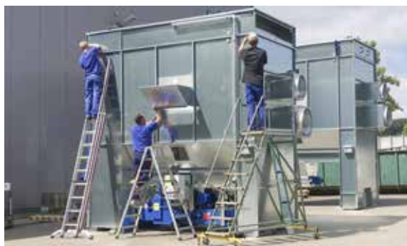
Zainstalować pion gaśniczy, blachę kierunkową płomienia, sterowanie układem regeneracji oraz podłączyć silniki. Skończone.
