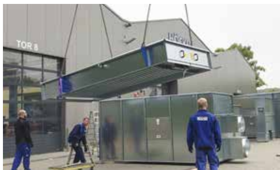
Moduł dachowy należy umieścić na module filtracyjnym i skręcić to razem.
