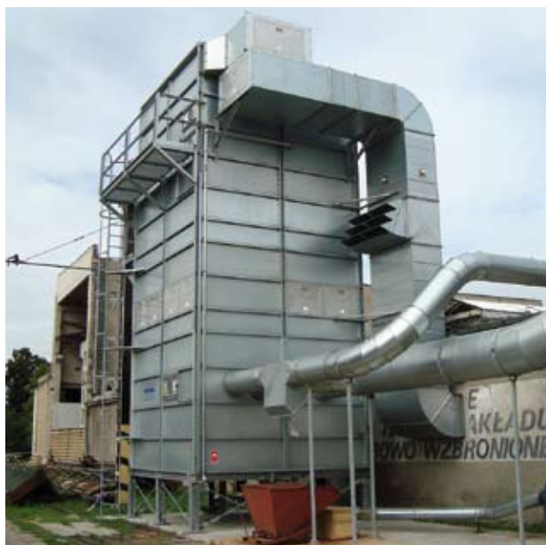
Filtr typu MultiStar JR ze zbiornikiem buforowym.
