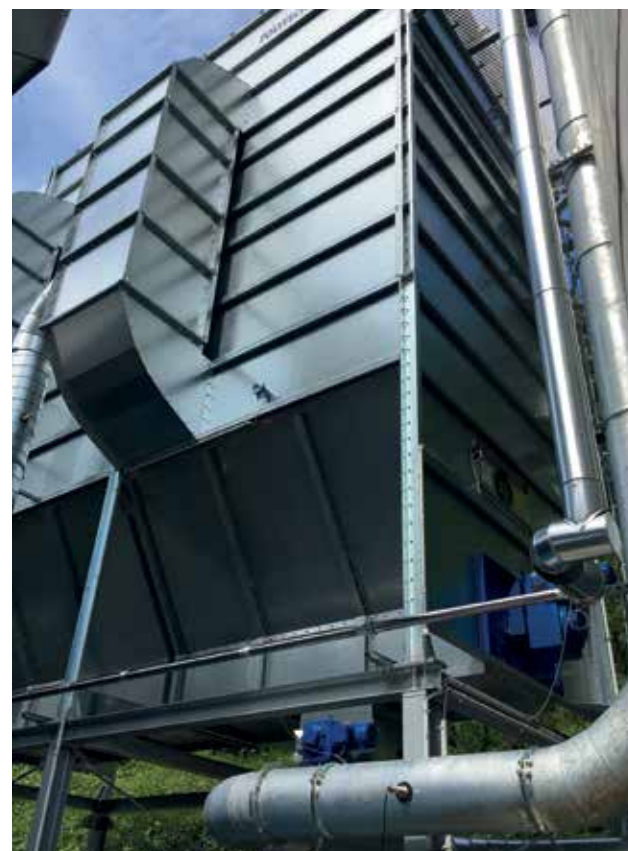
Materiał jest oddzielany za pomocą specjalnej technologii nadmuchu DUO i potem filtrowany. Fot. Höcker Polytechnik
