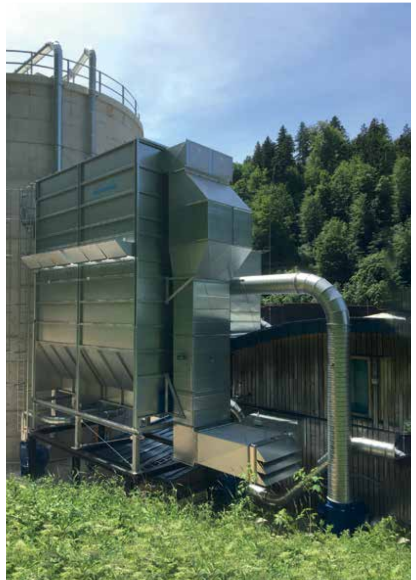
„Wspólnie z dealerami maszyn Grupp i Höcker Polytechnik zaplanowaliśmy urządzenia peryferyjne do odpylania dla nowej linii. System pracuje cicho i efektywnie, dzięki czemu wykonuje bardzo dobrą pracę” – mówi Timo Poschenrieder.
