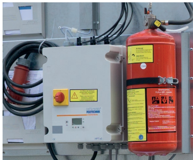
Ilustracja dolna: Sterowanie SPS, seryjnie z automatyką włączeniową maszyny oraz, Wbudowana automatyczna proszkowa instalacja gaśnicza
