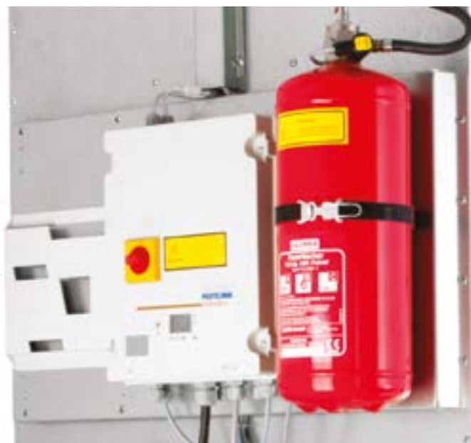
Ilustracja dolna: Sterowanie SPS, seryjnie z automatyką włączeniową maszyny oraz, Wbudowana automatyczna proszkowa instalacja gaśnicza
